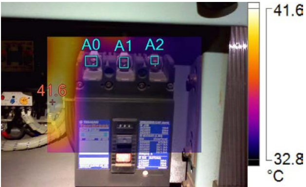
IR005970.IS2-No 2 Pump room fan
